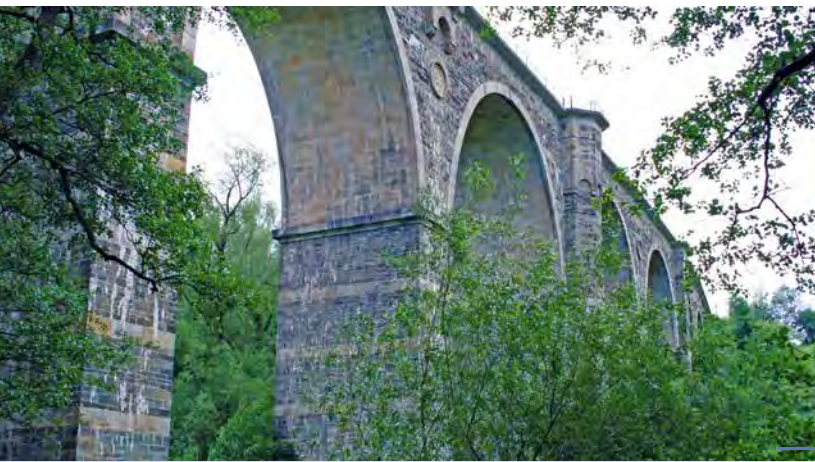
Syratalbrücke Foto: Stadt Plauen
