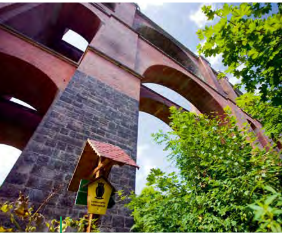
Elstertalbrücke Foto: TVV, C. Beer
